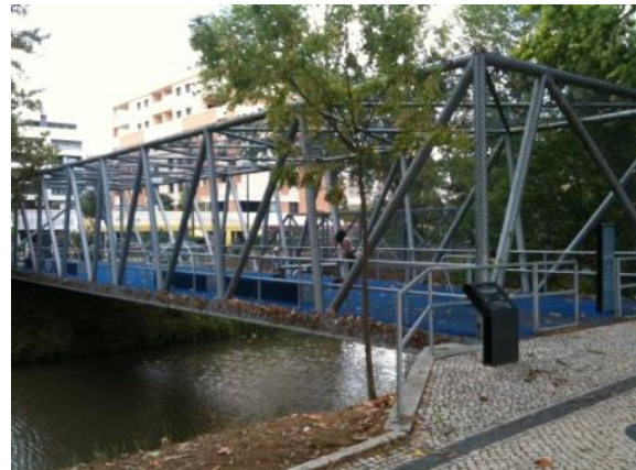
Figura 47 – Ponte Parque Infantil
