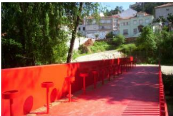
Figura 34 – Ponte Bar (Patrício, 2009)
